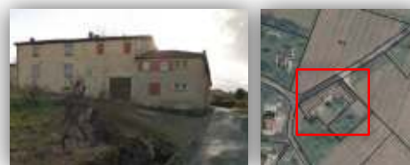
34. EBP 2. anc. bâtiment agricole - Chapenay
