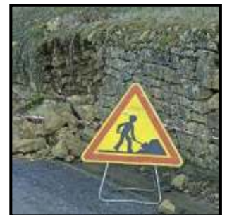
283 – mur en ruine
