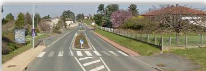
2. Entrée Sud et Est par Anse
