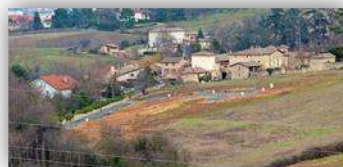
extension pavillonnaire des hameaux
