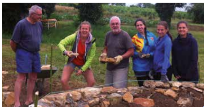
Chantier du jardin aromatique
